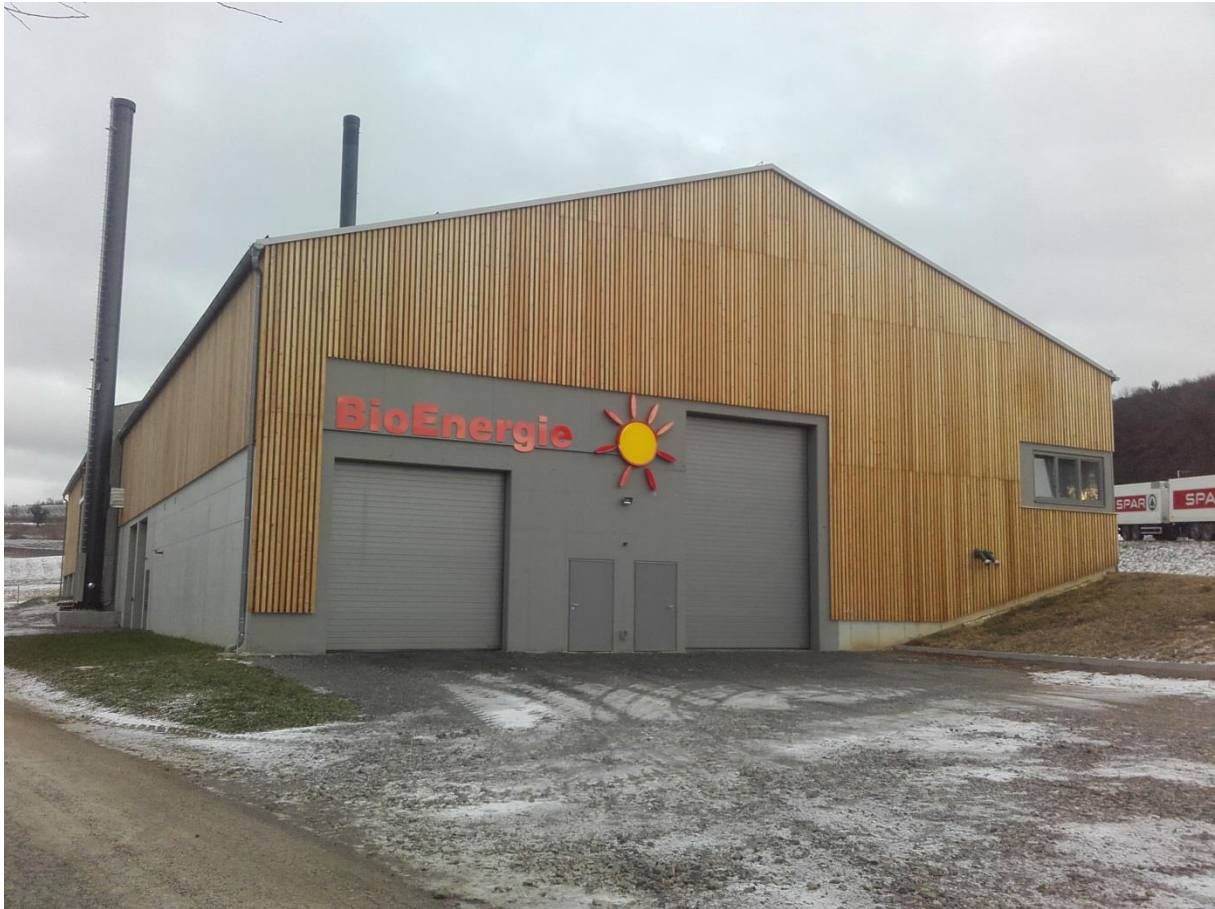
Biomasseheizwerk Bioenergie Pischelsdorf / Stmk.
