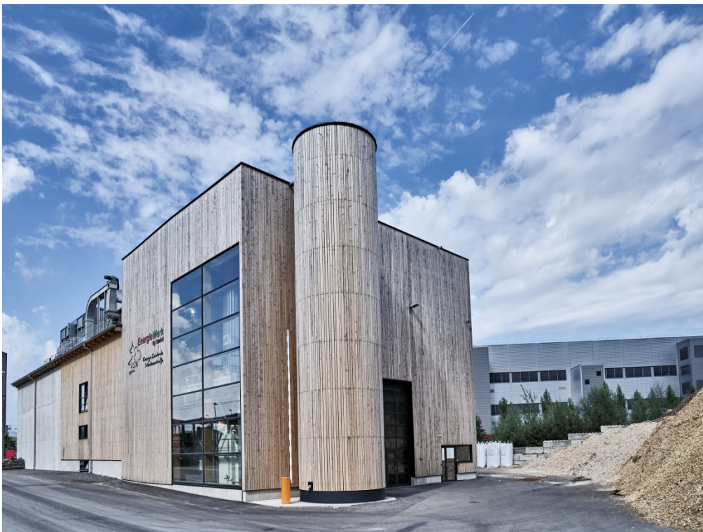
Energie Werk Ilg GmbH
